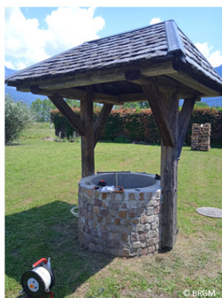
Puits maçonné (vue extérieure)
